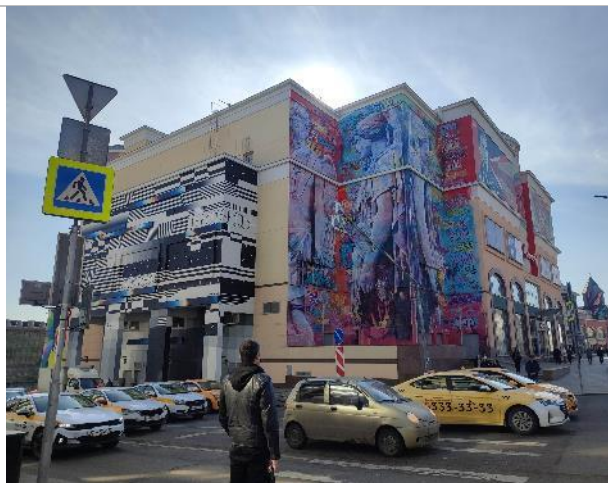
Фотография 3.1. Внешний вид здания
